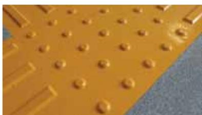
危険箇所や施設等の位置を示すブロックです。階段前、横断歩道前、誘導ブロックが交差する分岐点、案内板の前、障害物の前、駅のホームの端などに設置されています。
